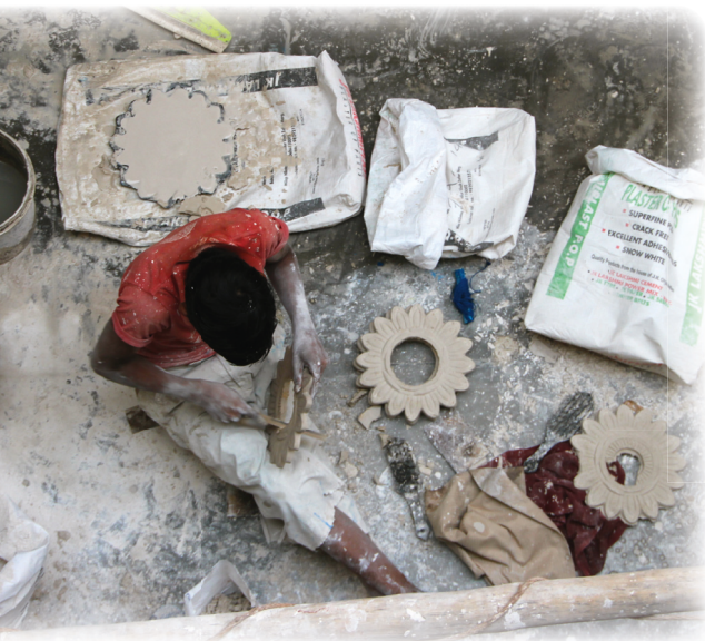
Herstellung der Deckenornamente
